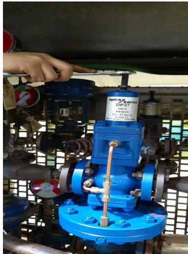
Gambar 12. Cara Setting PRV
